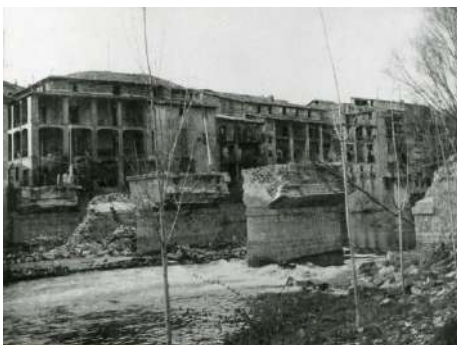
9 Voladura pont del ferrocarril (Autor. E. Graells. Arxiu Comarcal del Ripollès)
